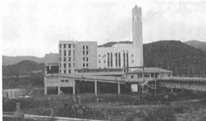
①取り残されたごみの一部を自治会がステーションに掲示。分別を呼びかける ②倉庫のような形状のステーションも。資源物の水濡れも防止している ③環境センターの外観
