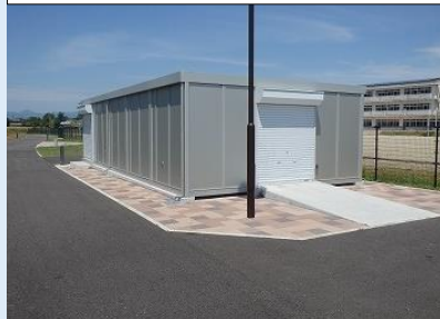
備蓄倉庫イメージ
