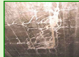
コンクリートのひびわれ
