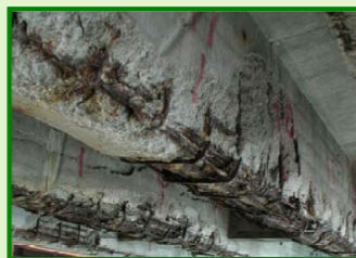
コンクリートの剥離・鉄筋露出
