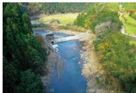
関西電力三田水力発電施設
