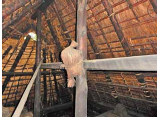
写真 5-32 笠松邸（小峠集落）垂木構造の小屋組
