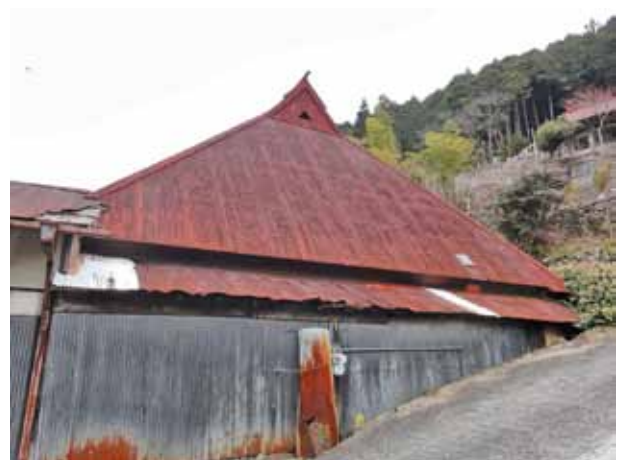
写真 5-27 トタン張茅葺民家
