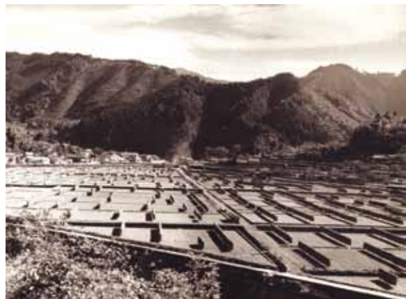
写真 3-33 圃場整備後の西原湯子田地区 昭和 39 年撮影
