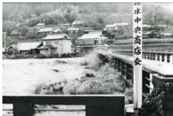
写真3-21 第2室戸台風による河川の増水 昭和36年9月撮影 写真右は清水橋
