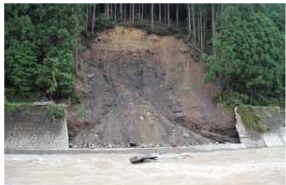
写真 3-41 上湯の被災状況
