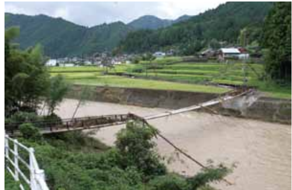
写真 3-37 水害直後の西原湯子田の状況
