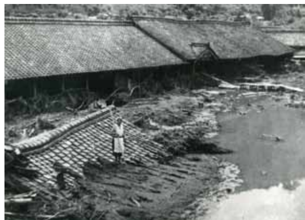
写真 3-25 水害直後の粟生小学校
