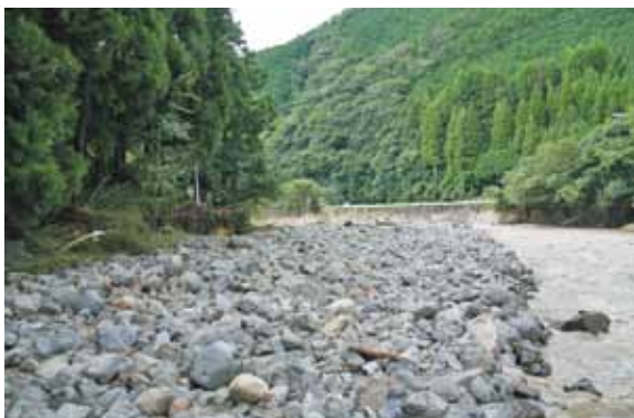
写真 3-40 水害直後の上湯取水口の状況
