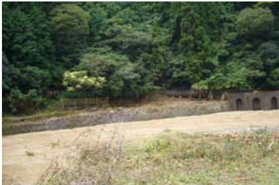
写真 3-36 水害直後の三田水力発電
