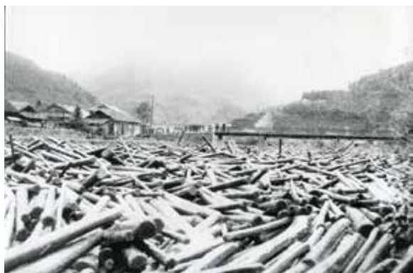
写真3-20 流木で埋め尽くされた有田川 昭和11年4月25日撮影 写真奥は清水橋
