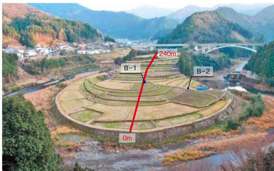
写真 2-5 ボーリング調査及び表面探査測線位置（展望台より撮影）
