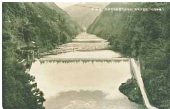
写真 1-35 三田用水（三田地内） 7.18 水害により発電所が壊滅し、 二川ダム建設に伴って堰堤も破壊された。
