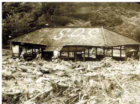
写真 1-36 沼谷分校の被災状況（昭和 28 年 7 月）
