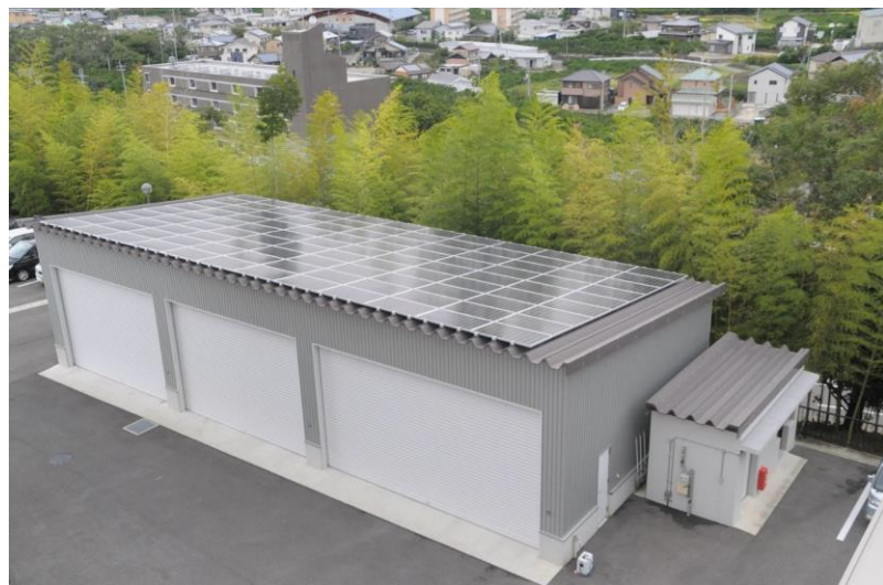
消防本部屋上及び車庫に設置している太陽光発電設備
