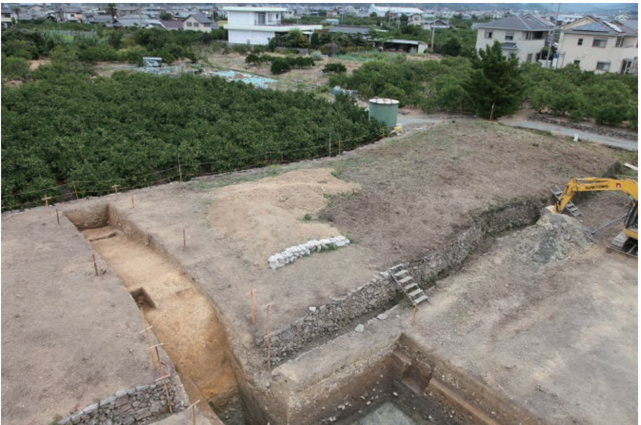
写真49 第3期土塁（南西から）
