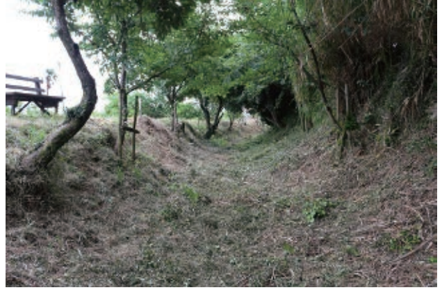
写真27 北堀・土塁（西から）
