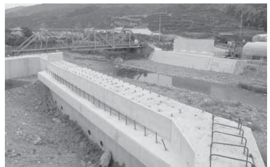
建設中の市場バイパス橋りょう工事(中野地区内)
