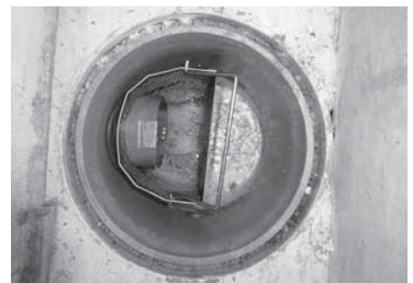
上から見た下水道分離マス
