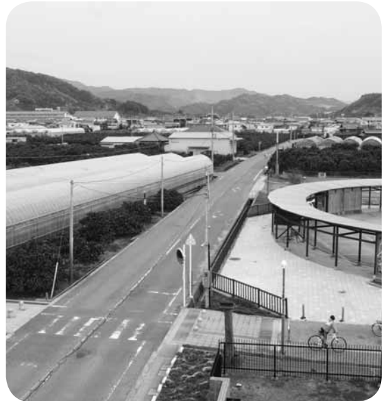
白線の消えかかった町道吉備中央縦貫線（ALEC前）
