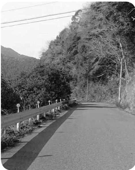
雑木が生い茂り見通しの悪い国道
