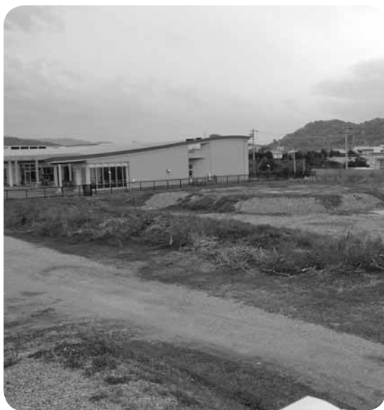
公共下水道吉備浄化センター建設予定地
