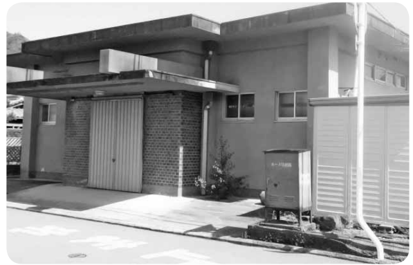
町が倉庫として使用していた建物
