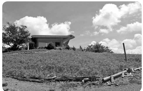
土止め柵の劣化が著しいコスモスパーク
