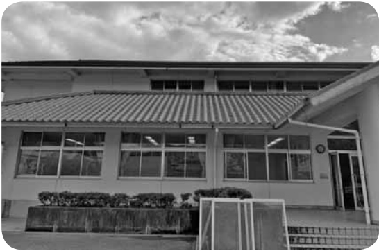
御霊小学校体育館
