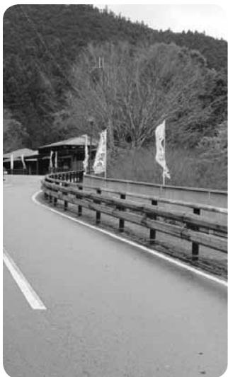
木製ガードレール
