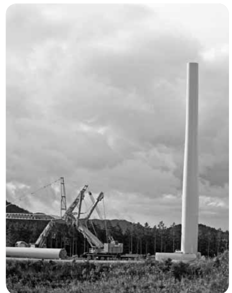
建設中の風力発電施設
