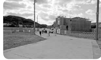
町道1017号線 下津野 (延長78・09m、幅員6m)
