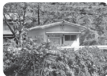
川合 消防団詰所
