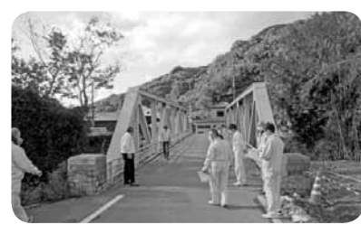
町道吉田青田線 小川 (延長324.8m、幅員5m)
