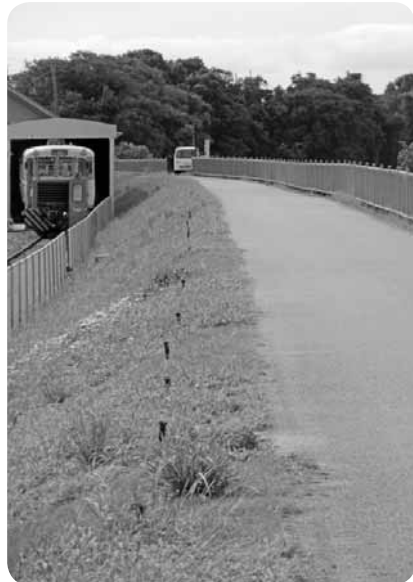
防犯灯設置が求められる町道徳田堤防線
