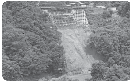
あらぎ島付近の崩落
