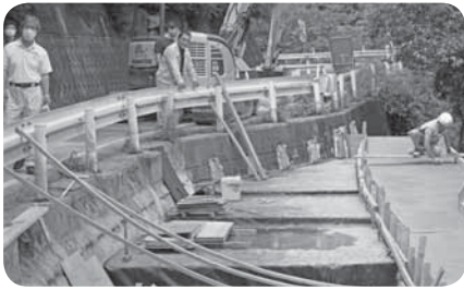
国道424号（有原地内）
