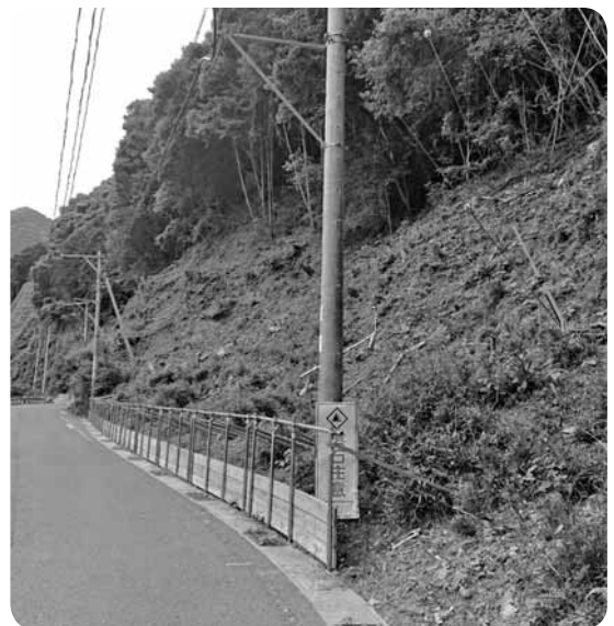
法面の木の伐採（国道480号 川口地内）
