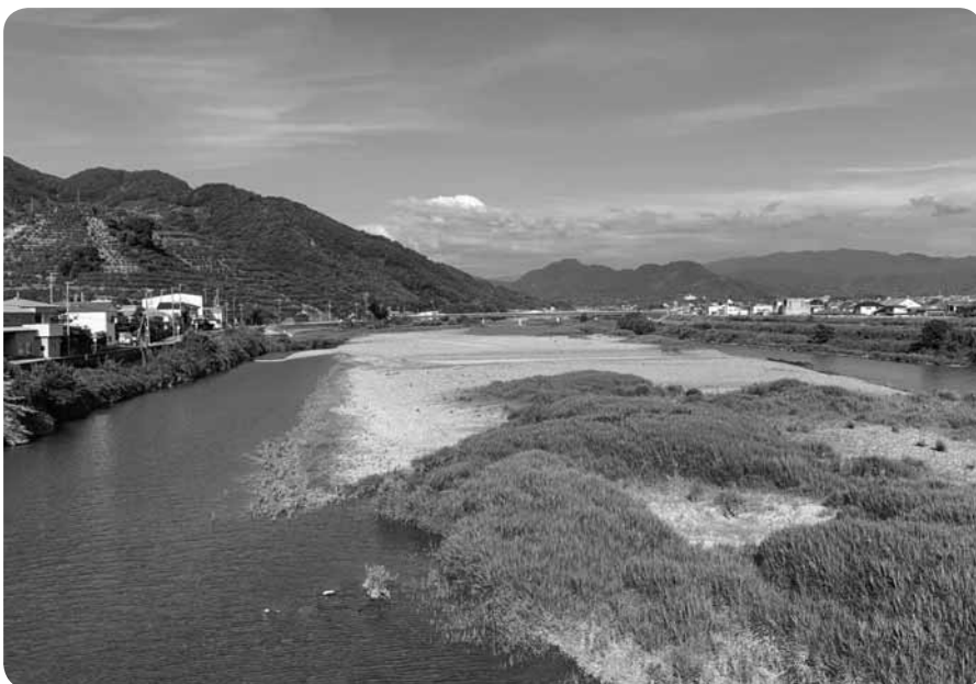
田殿橋から上流を望む
