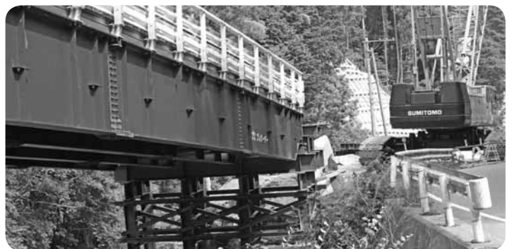
(仮称)鏡石トンネル付帯工事 上六川地内
