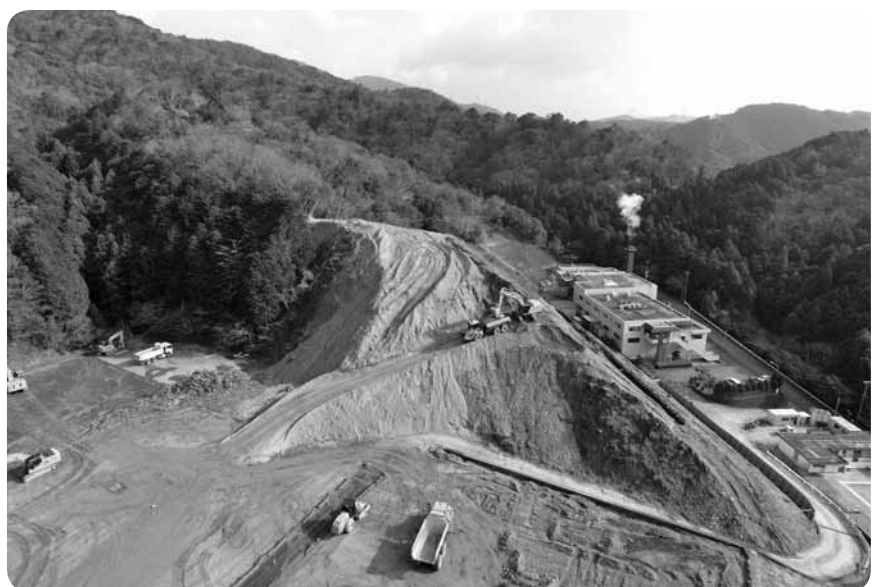
造成中のクリーンセンター敷地（長谷川）
