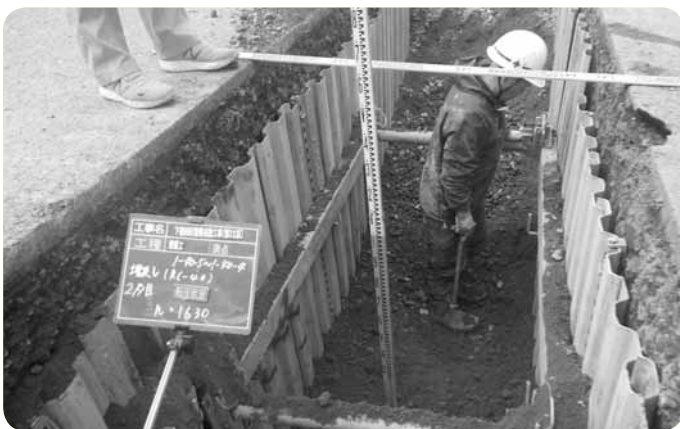
整備が進む公共下水道工事
