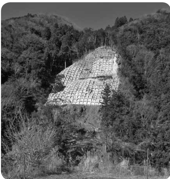
工法の変更が生じた町道板尾大橋沼谷線
