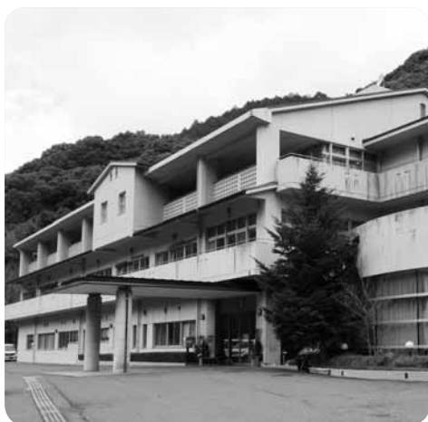
自家発電機の設置が予定されているしみず園
