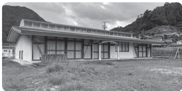
解体撤去予定の二川保育所
