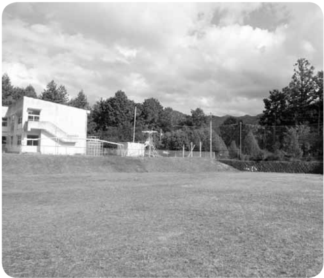
安諦小学校グラウンドヘリポート整備
