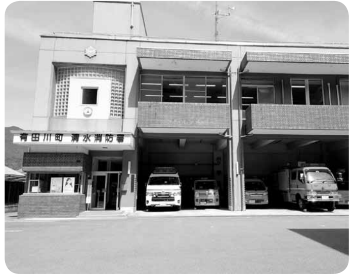
老朽化が進む清水消防署
