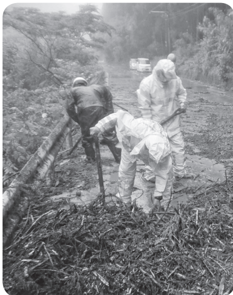
道路復旧作業に消防団員が出勤することも
