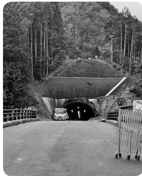
貫通した(仮称)鏡石トンネル
