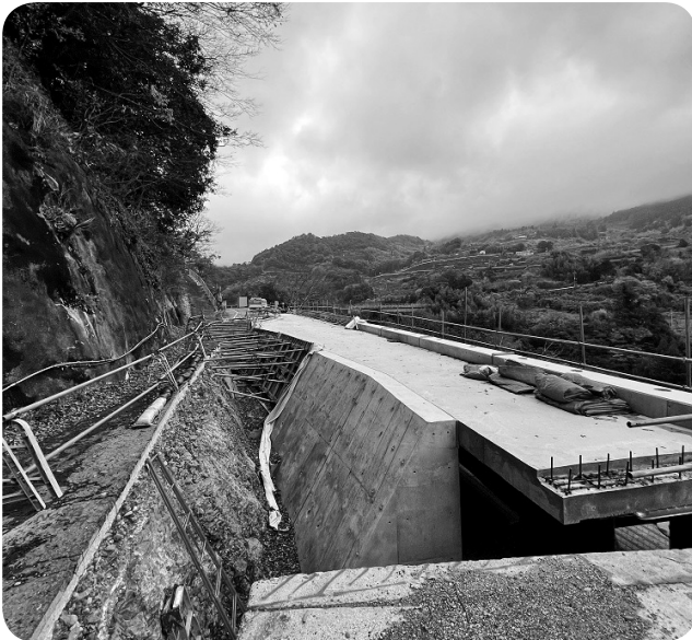
工事中の国道424号(西ヶ峯地内)
