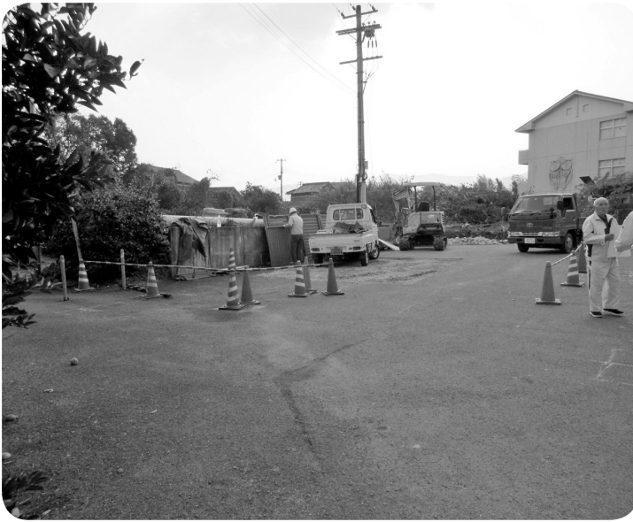
建設中の金屋学童保育施設を視察
