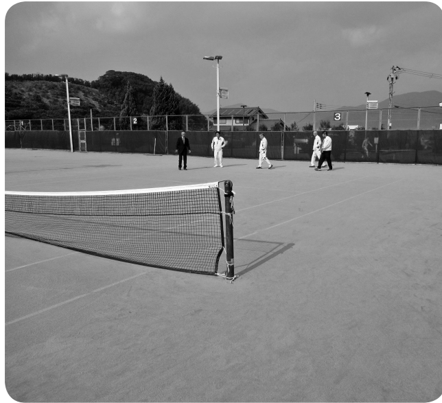
損傷が激しい人工芝（金屋テニス公園）
