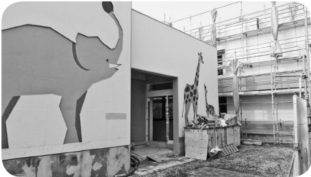
建設中のファミリー産院ありだ
