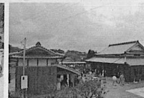
改修された古民家
