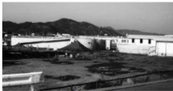
下水道終末処理場工事現場(下津野地内)
