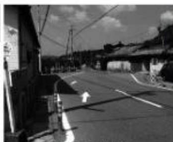
国道480号 長谷川地内
