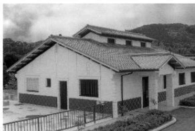
平成11年4月完成 吉原浄化センター(農業集落排水)
