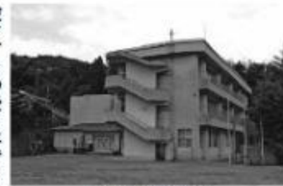
旧北小学校(湊井地区)
