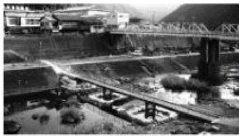
二川橋下に仮設された仮橋
