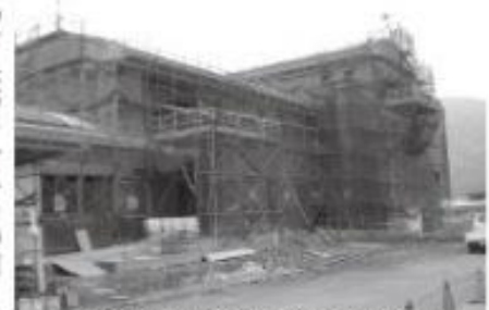
建設中の公共下水道終末処理場(野田地区)
