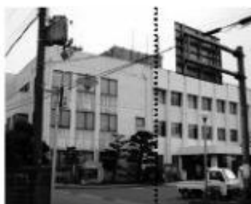
金屋庁舎の撤去される部分(点線部より左側)
