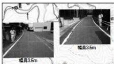
国道480号線の狭小な箇所
