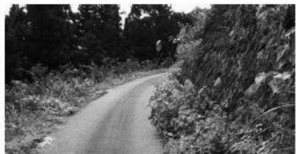
町道江西線(橋本地内)
