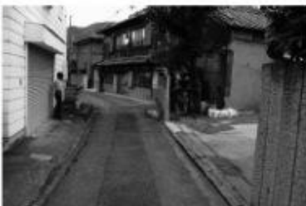
排水対策が求められている町道
