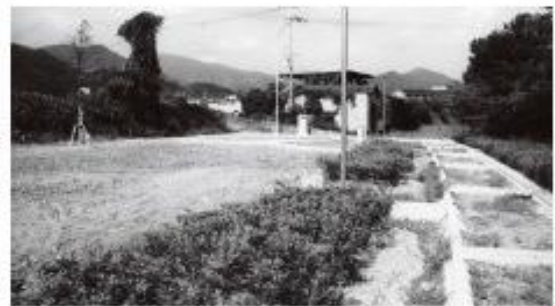
建設中の鉄道公園
