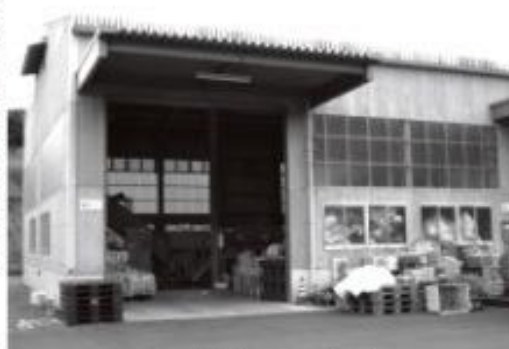
有田川町プラスチック収集場
