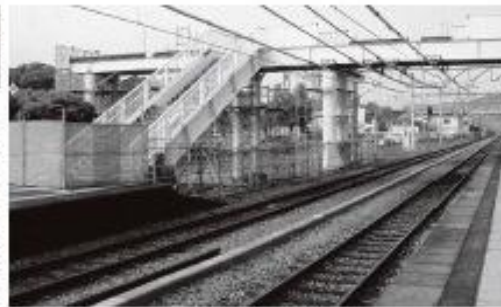
解体中の跨線橋
