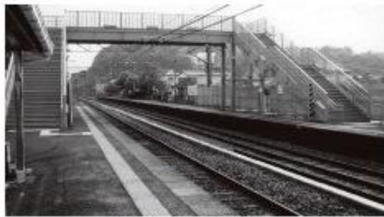
藤並駅ホーム、仮跨線橋
