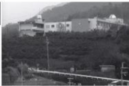
改修が急がれる金屋中学校
