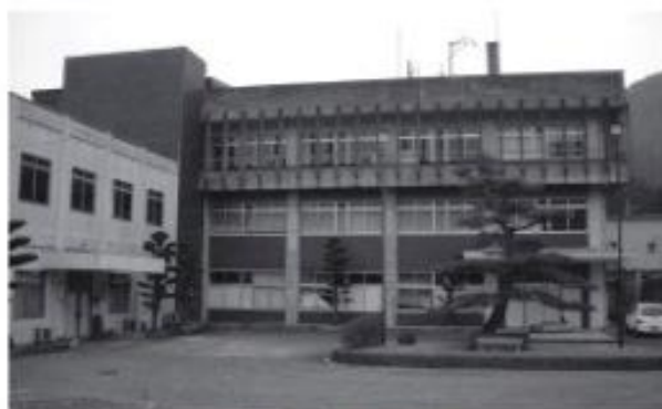
解体される旧清水庁舎
