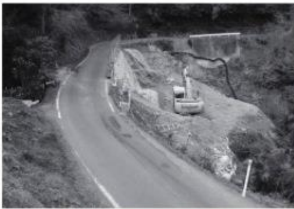
なかなか進まない小規模改修工事(西ヶ島地区)
