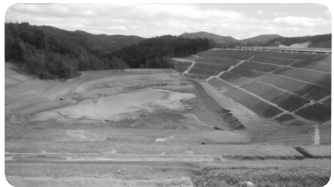
上六川メガソーラーの調整池
