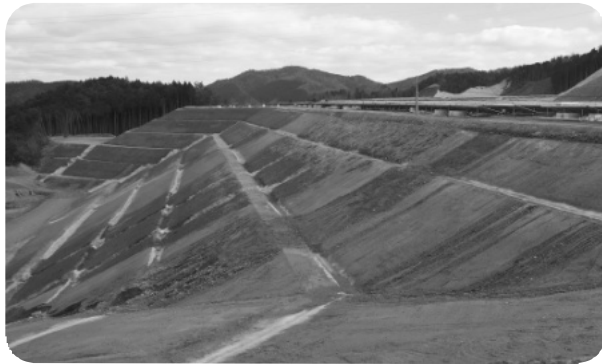
大規模な盛土の法面
