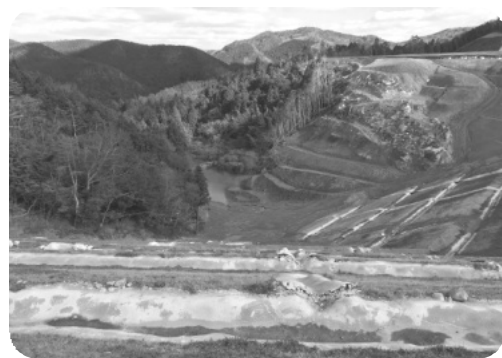
上六川メガソーラーの調整池
