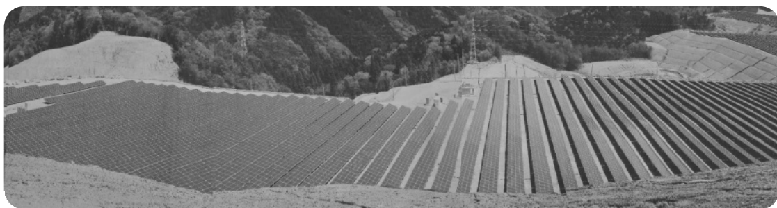
上六川メガソーラー発電施設
