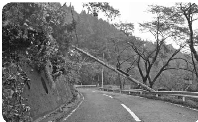
台風により破損したケーブル
