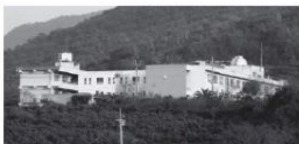
金屋中学校全景
