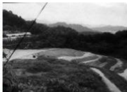
土砂の搬入がされている養鶏団地(野井地内)
