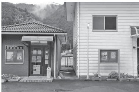
安諦出張所との間に入ると右側にトイレ
