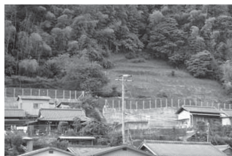
すでに急傾斜地対策を行っている場所（栗生地区）
