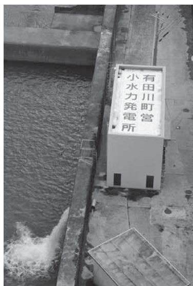
全国から注目されている 二川小水力発電所
