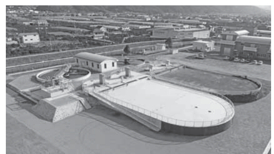
現在の吉備浄化センター
