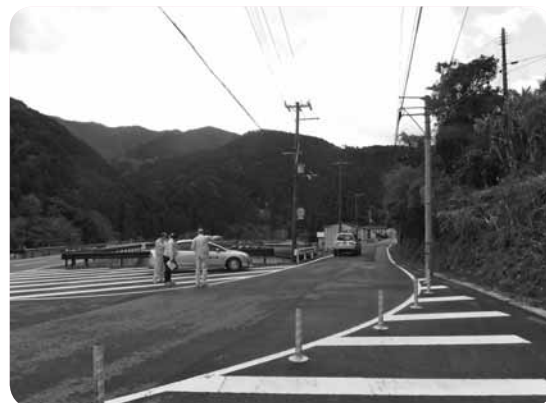
町道川口岩野河線（岩野河地内）
