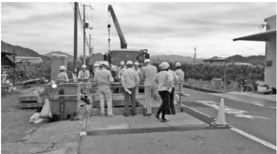
下水道工事現場
