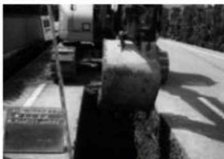
下水道工事現場
