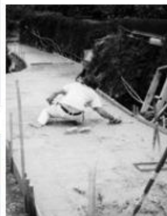
6くらく運搬農道舗装
