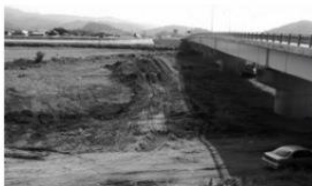
有田川の浚渫現場(日輪橋付近)
