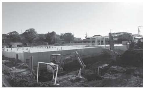
吉備会館跡地に建設中の新統合保育所
