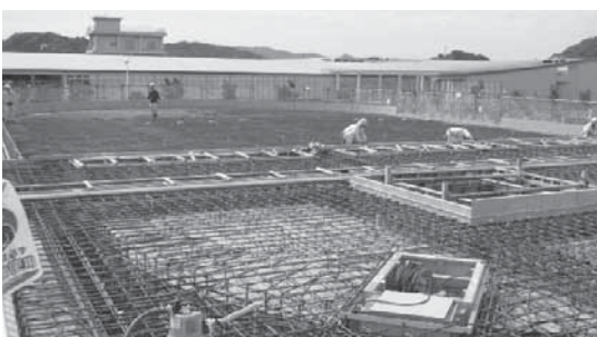
建設中の下水道終末処理場（吉備浄化センター）
