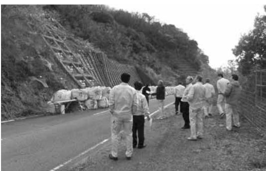
町道田口千葉山線道路災害復旧現場の調査
