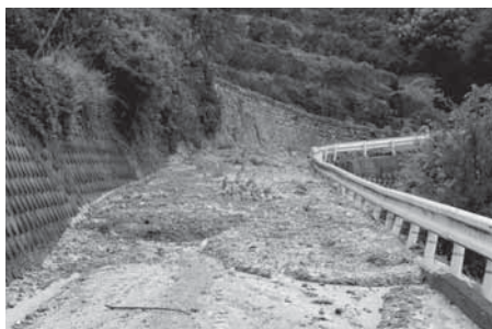
町道へ土砂が流出（西ヶ峯地内）
