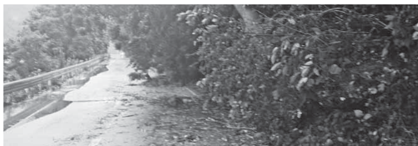
大木が覆いかぶさり一時通行止めとなった国道480号（岩野河地内）
