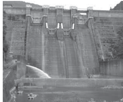
小水力発電施設を設置予定
