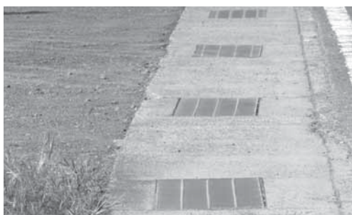
側溝のグレーチング
