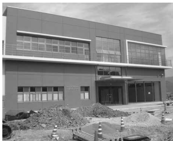
12月21日竣工に向け建設が進む新消防庁舎(徳田地内)
