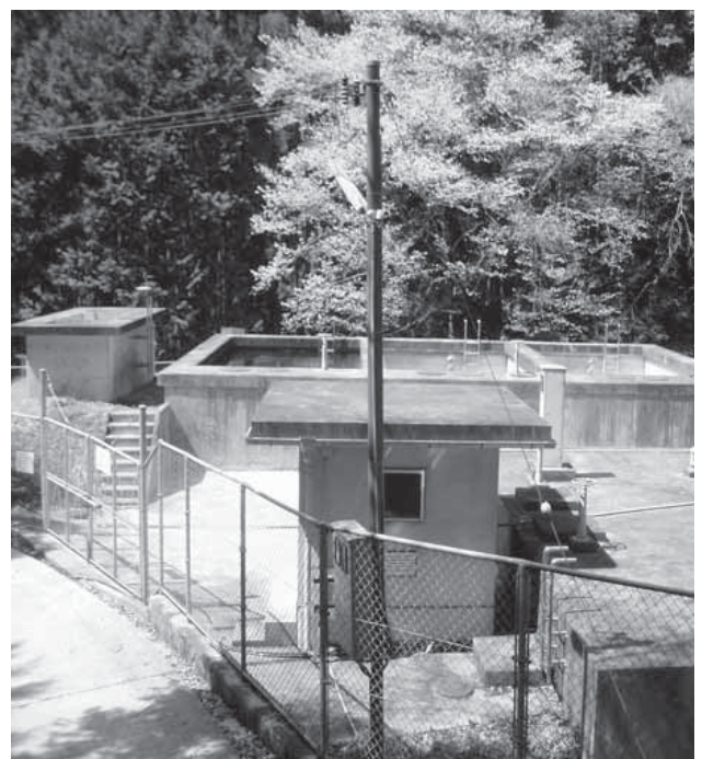
久野原簡易水道施設
