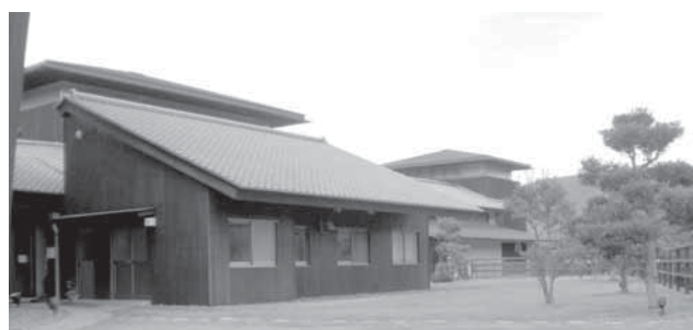
屋根に太陽光発電を設置予定のかなや明恵峡温泉施設
