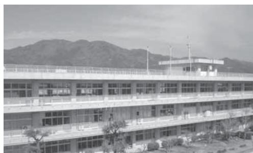
解体される旧吉備中学校校舎
