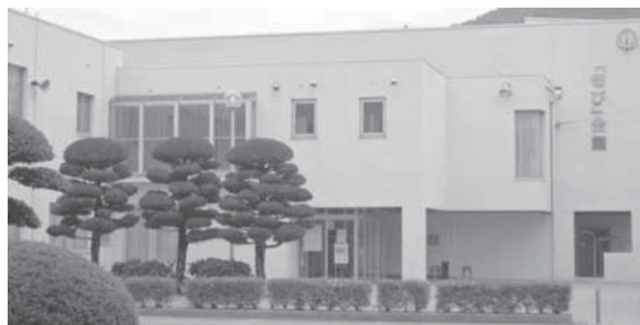
老朽化したきび会館
