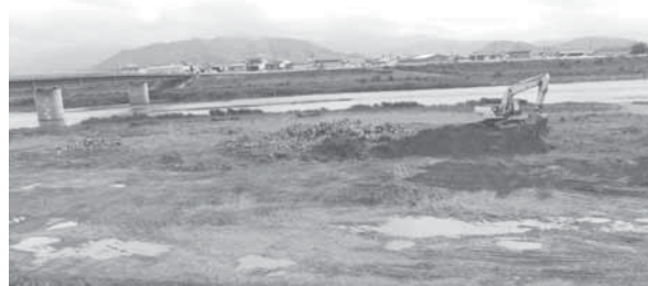
有田川での堆積土砂採取現場（田殿地区）
