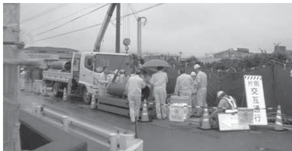
下水道工事現場を視察
