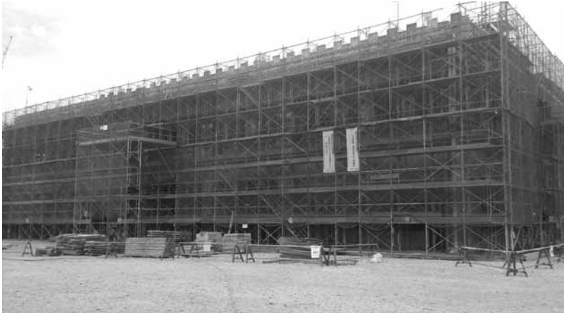
建設中の消防本部庁舎（徳田地内）
