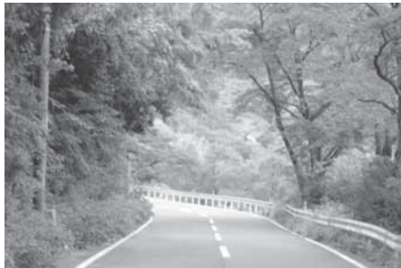
国道480号（楠本地内）
