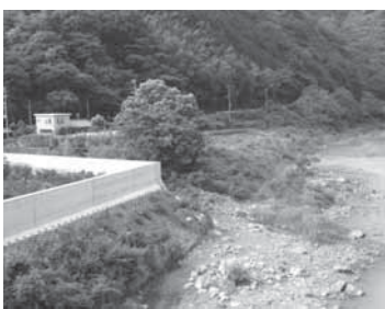
堤防嵩上げ工事現場 (岩野河地区)
