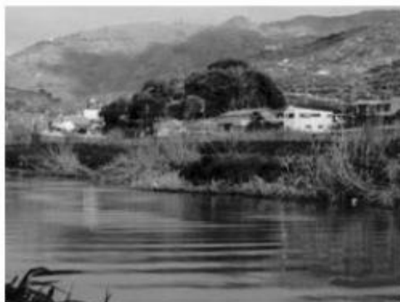
吉備橋～田船橋間では、堆積土砂は2mにも達し、暴雨による堤防の決壊が心配される。
