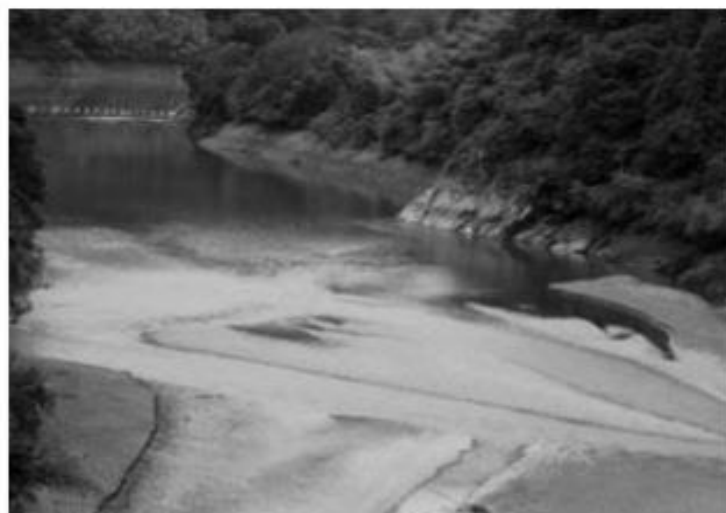
境川橋からおしどり岬までの堆積した土砂
