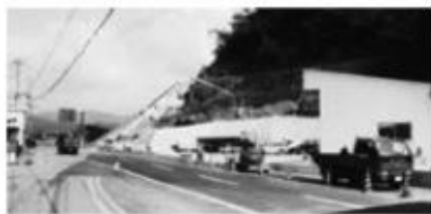
堀倉地内の工事現場
