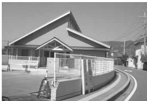
新しく建てられた藤並学童クラブ第二施設(4月20日竣工)
