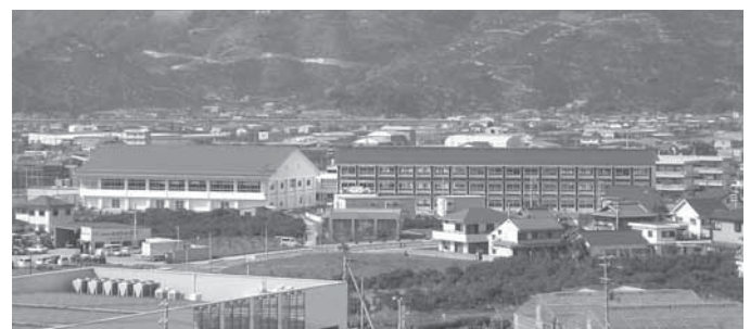
完成した新吉備中学校校舎
