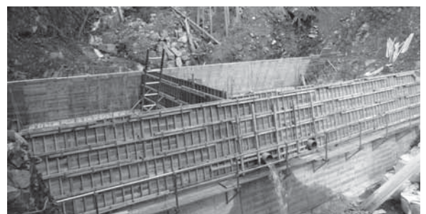
横谷川の砂防ダム建設工事
