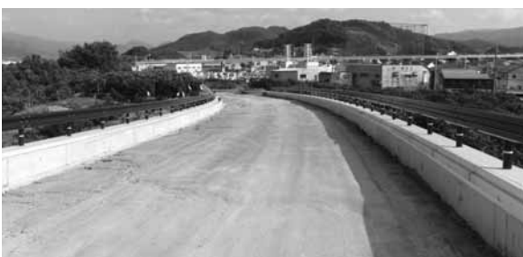
バイパス工事が進み利便性が期待される(水尻地内からJR紀勢本線を越えて国道42号へ通じる)
