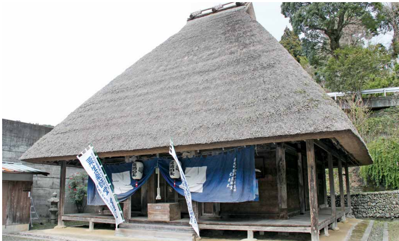
吉祥寺薬師堂（国指定重要文化財）有田川町粟生
