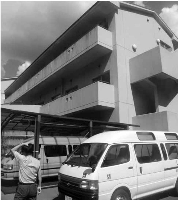
スロープが設置される特別養護老人ホーム しずみ園(二川地内)
