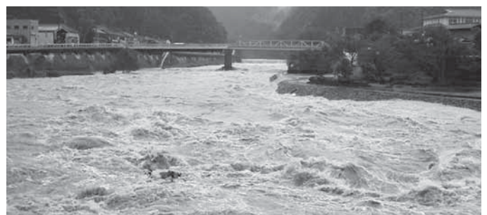
台風12号で激流となった有田川(二川地内)
