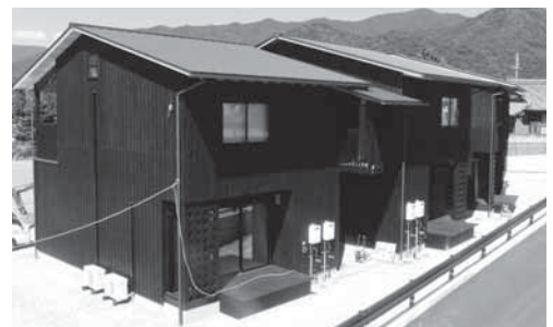
完成した宿泊棟(清水栗林地内)
