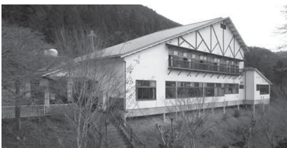
老朽化したあさぎり施設
