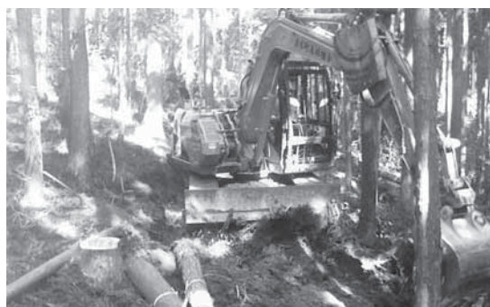
森林作業道の開設現場
