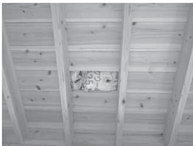
「わらし」作業棟の天井
