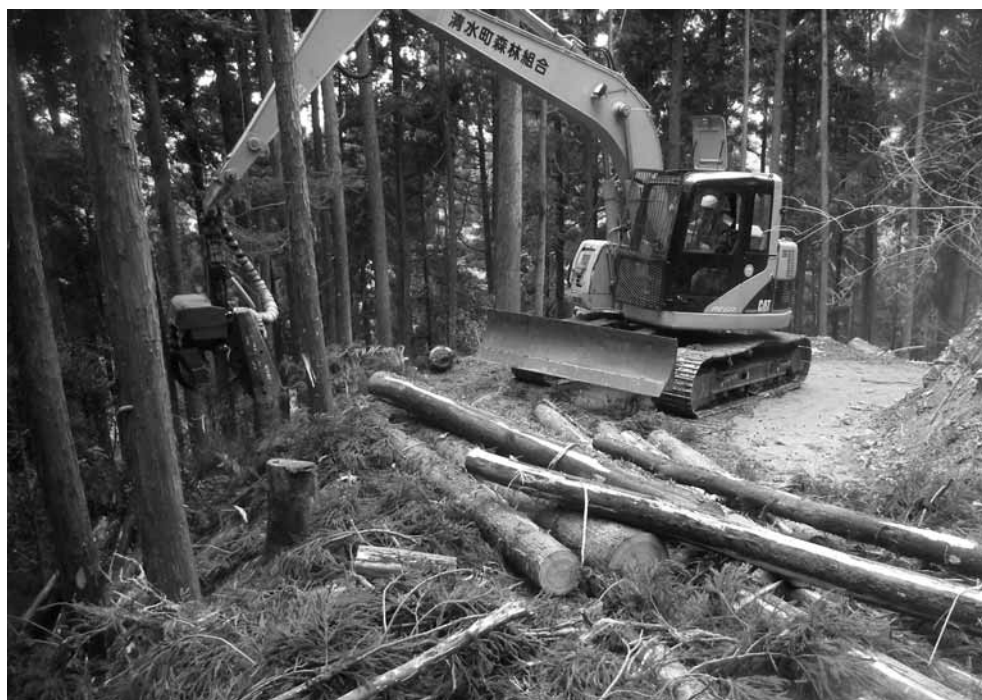
重機を使った間伐作業
