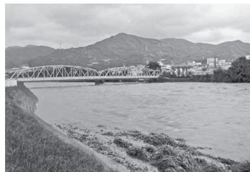
昨年の台風12号による増水状況(金屋橋付近)
