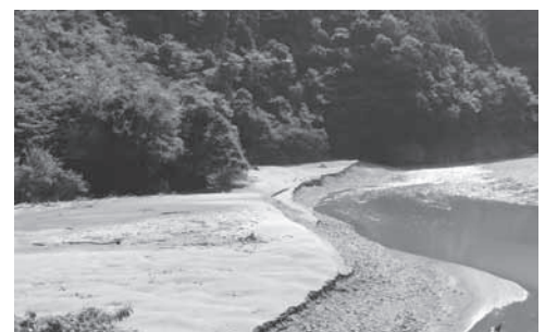
有田川の堆積土砂(遠井地内)
