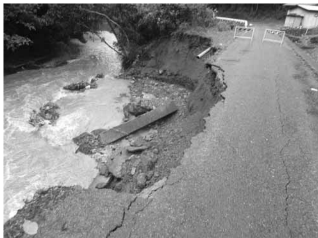
町道久野原沼谷線(沼谷地内)
