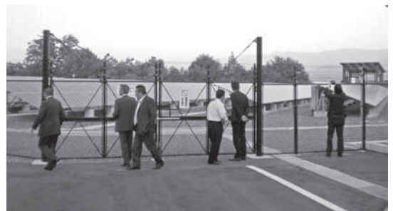
飯田市メガソーラー発電施設
