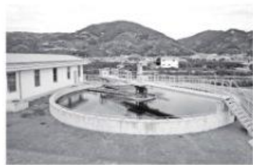
吉備浄化槽沈殿池(下津野地内)
