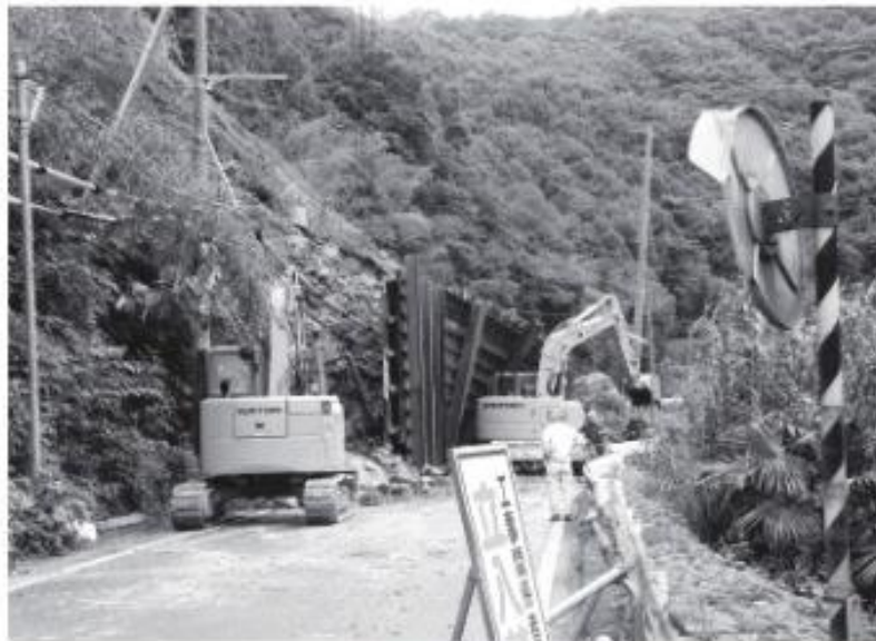
国道480号災害復旧作業中(川口地内)
