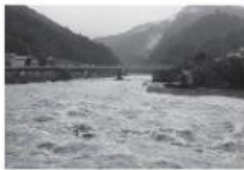
台風により氾濫する有田川(二川地内)
