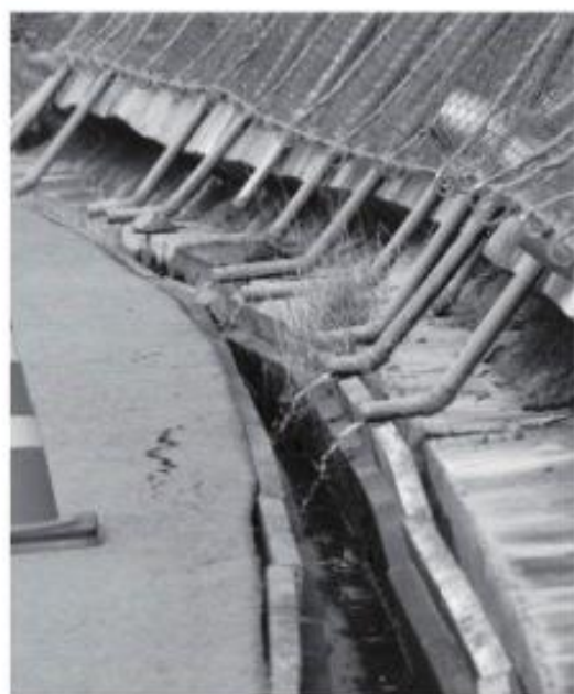
国道424号修理川バイパス(修理川地内)
