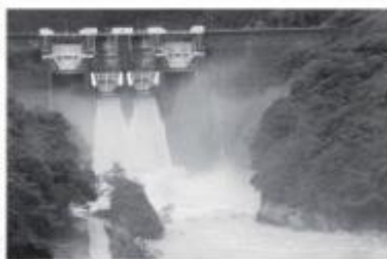
二川ダム(二川地内)
