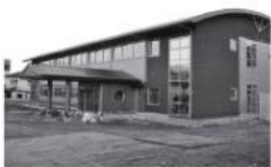
完成間近かな新金屋庁舎(中井原地内)
